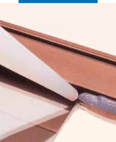
Fogning av fönsterram i aluminium med Mapesil AC
