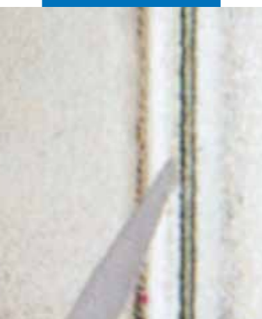
Glasfogning med Mapesil AC
