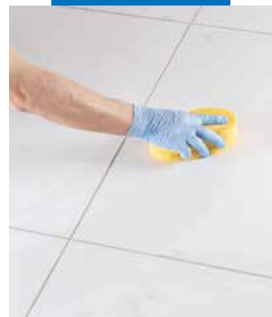
Rengöring och slutbehandling av plattfogar med cellulosa svamp
