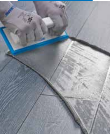
Fogning av Ultracolor Plus med gummispäckel på klinker med trä-stuktur
